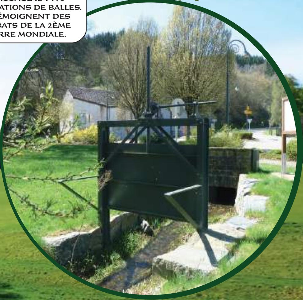
Aus dem Bach wird an einem **Hauptwehr** Wasser abgezweigt, das dann in einen oberhalb der Wiesen gelegenen Graben fließt. Dieser **Obergraben** wird wiederum angestaut durch die **Wehre 1 und 2**, so dass das Wasser in die **Seitengräben B1 bis B6** gelenkt wird. Überschüssiges Wasser wird in den **Entwässerungsgräben E1 bis E6** aufgefangen und fließt von dort in den **Strombach** zurück.
